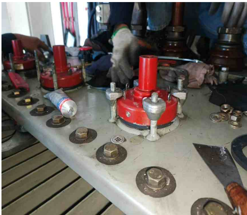
PROSES PEMASANGAN GASKET BARU HV ELASTIMOLD
