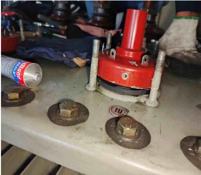
PROSES PEMASANGAN GASKET BARU HV ELASTIMOLD
